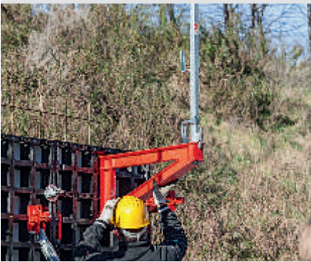
스캐폴딩 브래킷 듀오 70은 판넬 프레임 개방부에 끼워서 설치한다. 페리 안전 난간대는 별도의 고정 장치 없이 브래킷에 바로 설치할 수 있다.
