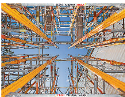
1992년, 페리는 고강도 알루미늄으로 만든 동바리를 출시하였다. 가벼운 자중과 높은 허용 하중, 스핀들 부위의 자가 청소 기능은 멀티프로 (MULTIPROP) 동바리의 가장 큰 성공 요소였다.
