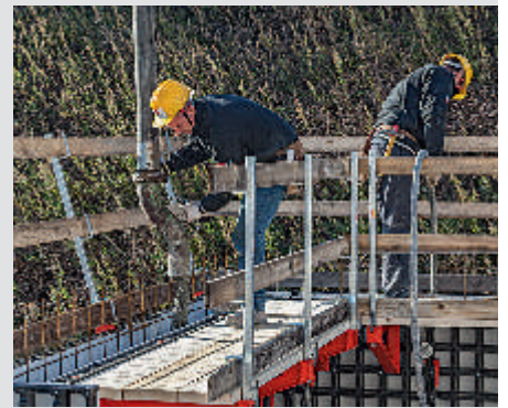
너비 70 cm의 작업용 발판과 반대면 안전난간을 설치하여 타설 작업 시 안전한 작업 환경을 확보할 수 있다.
