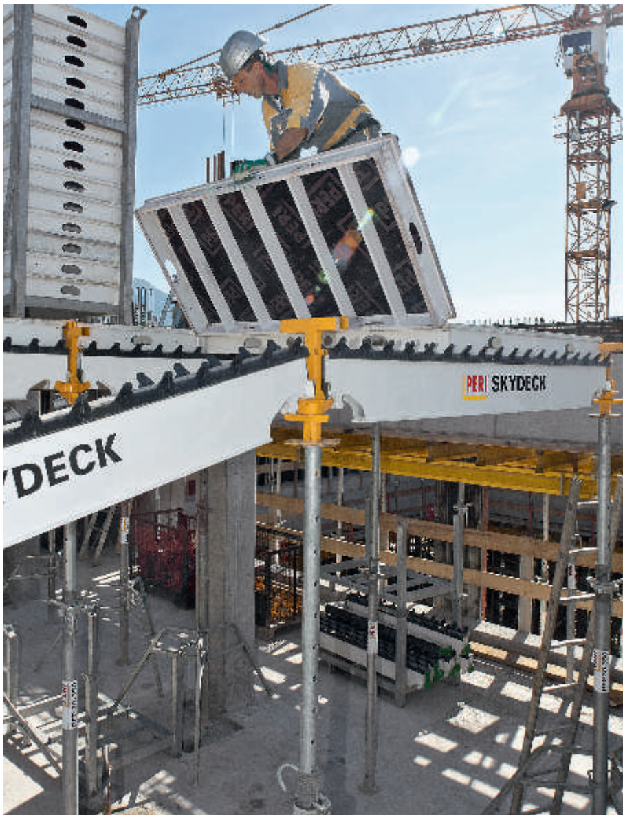
1992년, 페리는 고강도 알루미늄으로 만든 동바리를 출시하였다. 가벼운 자중과 높은 허용 하중, 스핀들 부위의 자가 청소 기능은 멀티프로 (MULTIPROP) 동바리의 가장 큰 성공 요소였다.
