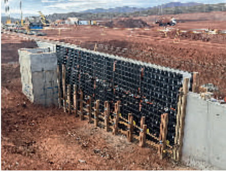
현장 구조물 대부분에 듀오 표준 패널이 사용되었고, 하부 경사면에는 합판 거푸집과 조합하여 운용되었다.
